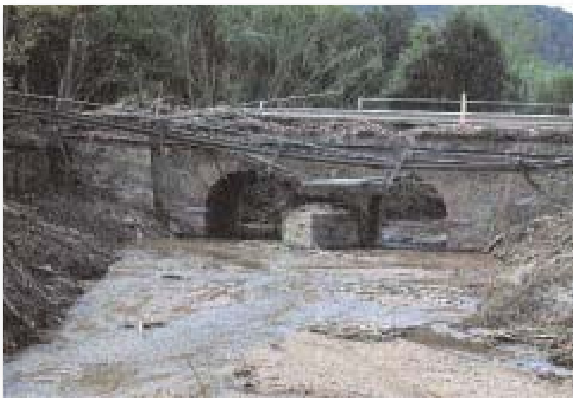
Figura 1.2.16: Ponte sul Fosso Litterno situato tra C. Verna e C. Miliani. Le protezioni della sede stradale sono state divelte dal passaggio dell'onda di piena, mentre parte dell'asfalto è stata asportata. Durante l'evento, la sezione di deflusso è stata completamente ostruita.
