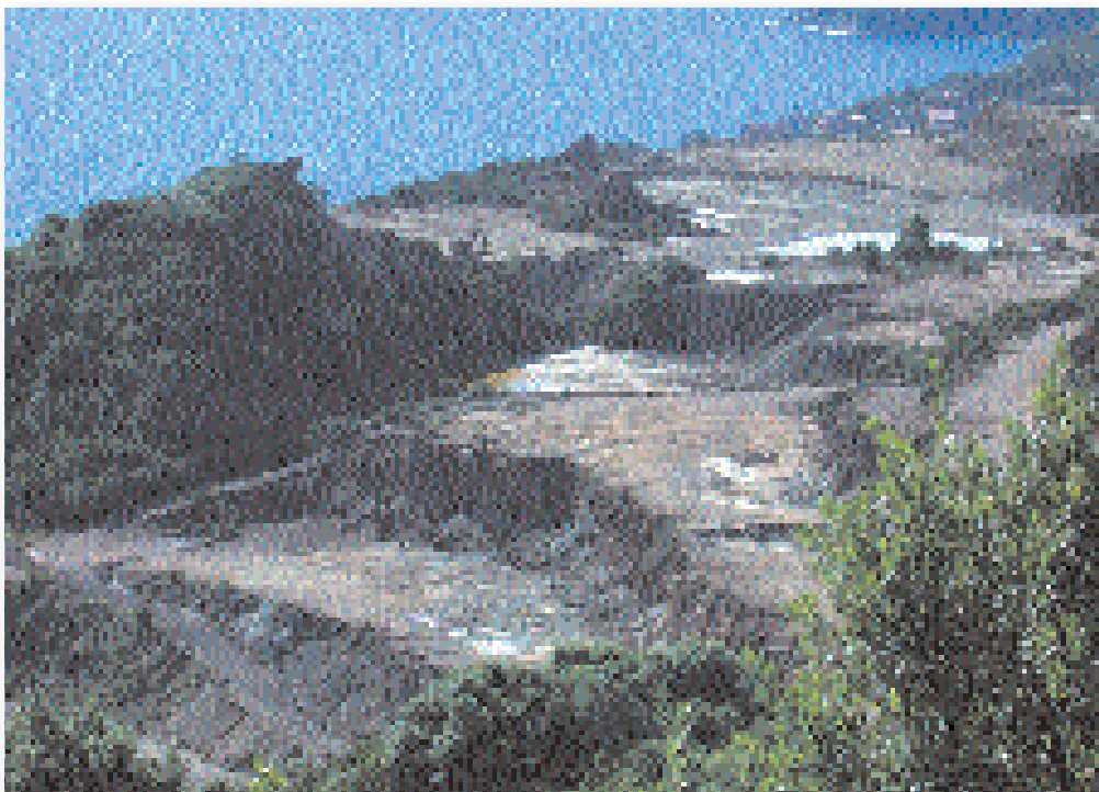
Figura 1.2.33: Rio Marina, fenomeni d'erosione sulle scarpate che delimitano i piani di coltivazione delle miniere.
