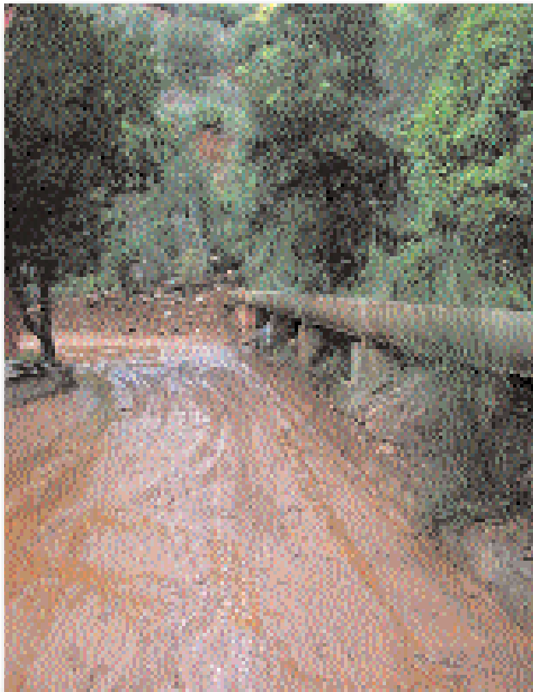
Figura 1.2.31: Canaletta in calcestruzzo allo sbocco del fosso per l'allontanamento delle acque di scorrimento superficiale, con sezione insufficiente di deflusso
