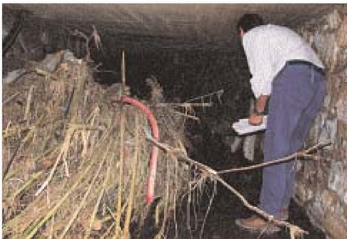
Figura 1.2.12: Biodola - fosso scatolare ostruito parzialmente da materiale vegetale
