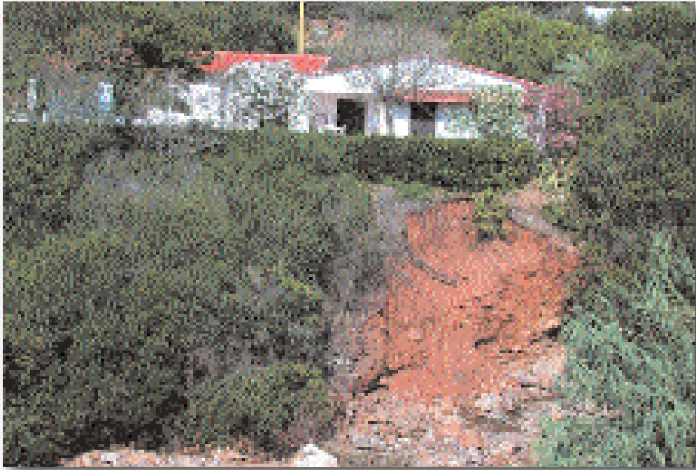
Figura 1.2.27: Fosso Pontimento, scivolamento corticale a monte dell'abitato di Morcone.
